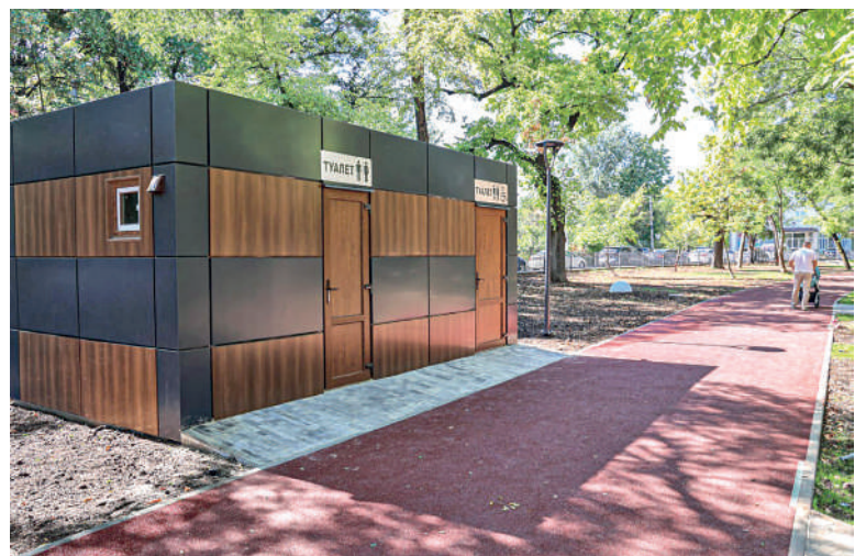
Новый туалет уже подключён к сетям. Он будет платным.
