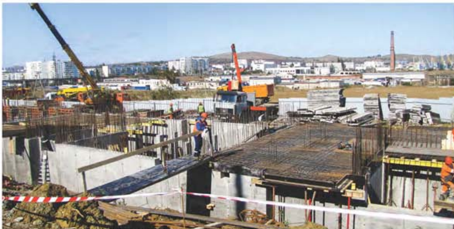
Новое жильё возводится ускоренными темпами, и уже в декабре переселенцы получают квартиры
