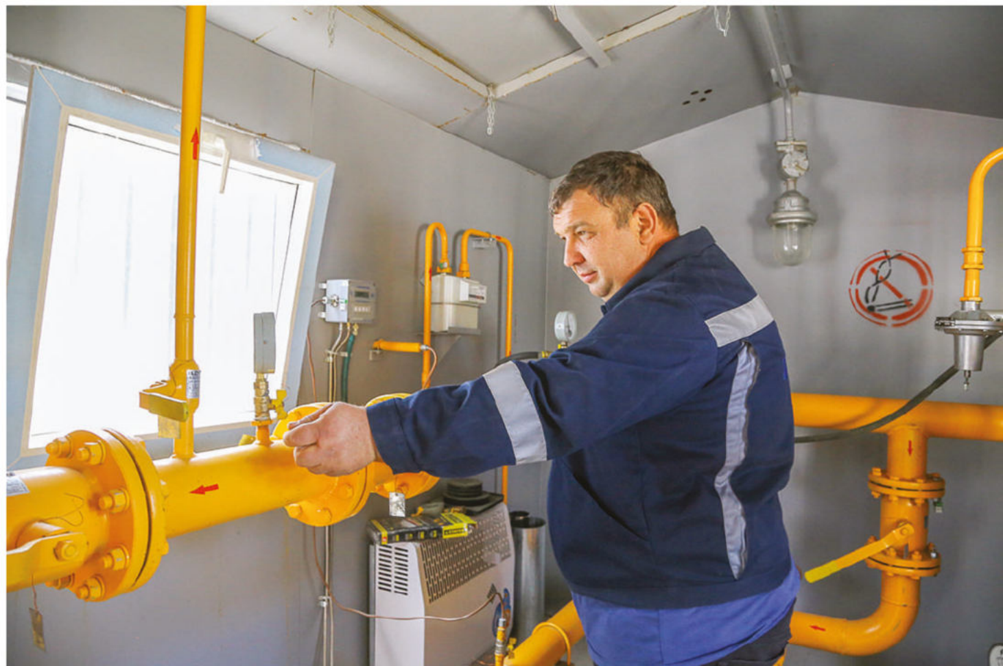
Проверка давления газа на газораспределительном узле в микрорайоне Сары-Су города Белогорска. Фото: Лидия ВЕТХОВА
