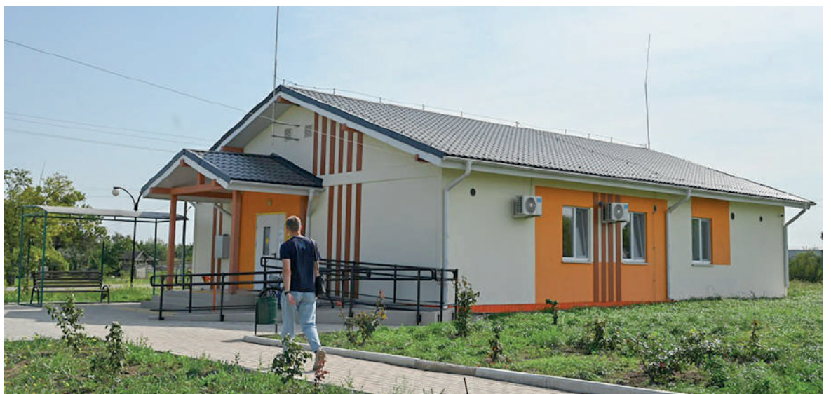
Строительства нового ФАПа ждали и медработники, и местные жители.
