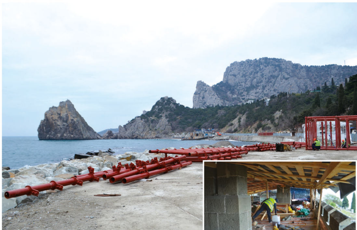
Объекты ФЦП самые разные: реконструкция берегоукрепительных сооружений в Симеизе и противоаварийные работы в Воронцовском дворце. Фото: Мария УСТИНОВА
