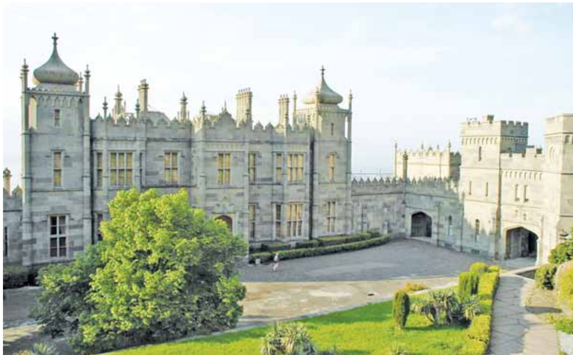
Воронцовский дворец. Через главный Северный парадный двор пройдёт канализация.
