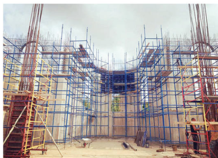
Строительство храма Великомученицы Екаторины в Симферополе. На фото — алтарная часть и стены. Фото из социальных сетей
