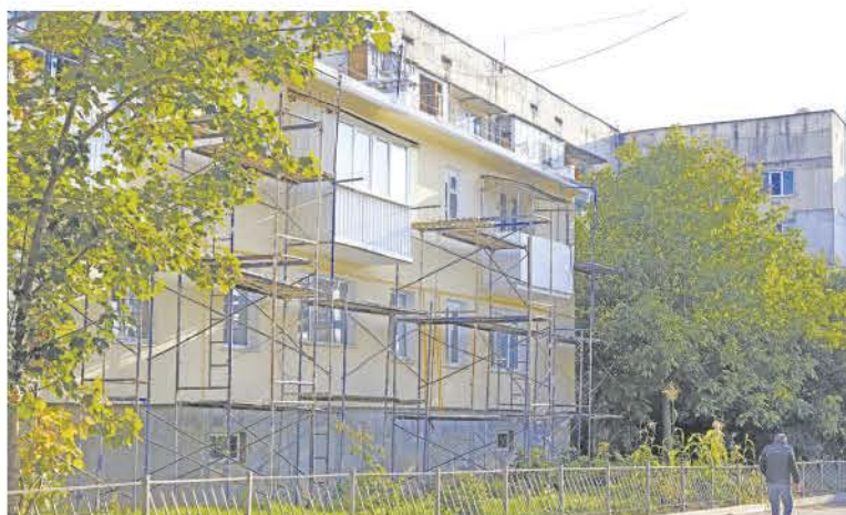
Капремонт многоквартирников в самом разгаре.
