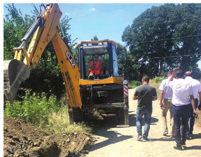
Начались работы по подаче воды жителям Богдановки.
