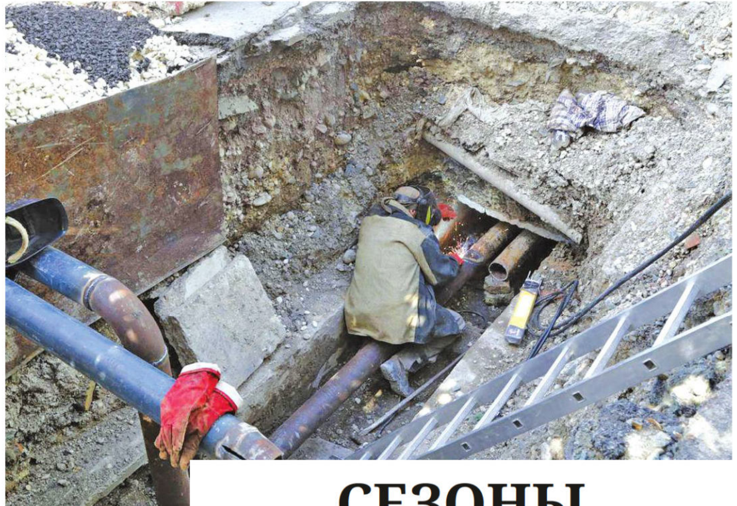
4 августа. Замена магистральной теплотрассы на Троллейбусном массиве (ул. Троллейбусная, дом 3). Фото: Наталья СОМОВА
