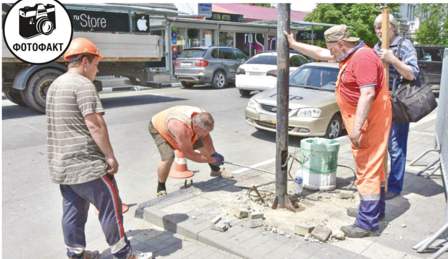
Симферополь, 18 июня. В центре крымской столицы в рамках подготовки Парада Победы демонтируют фонарные столбы. На их месте установят сцену. После парада фонари вернут. Работы проводит МБУ «Горсвет». Фото: Гала АМАРАНДО
