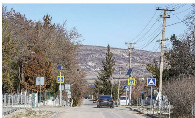
Ул. Ленина приведена в нормативное состояние.
