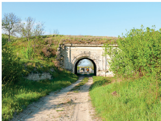
Все каменные сооружения Керченской крепости Тотлебен предусмотрительно защитил мощным слоем земли.
