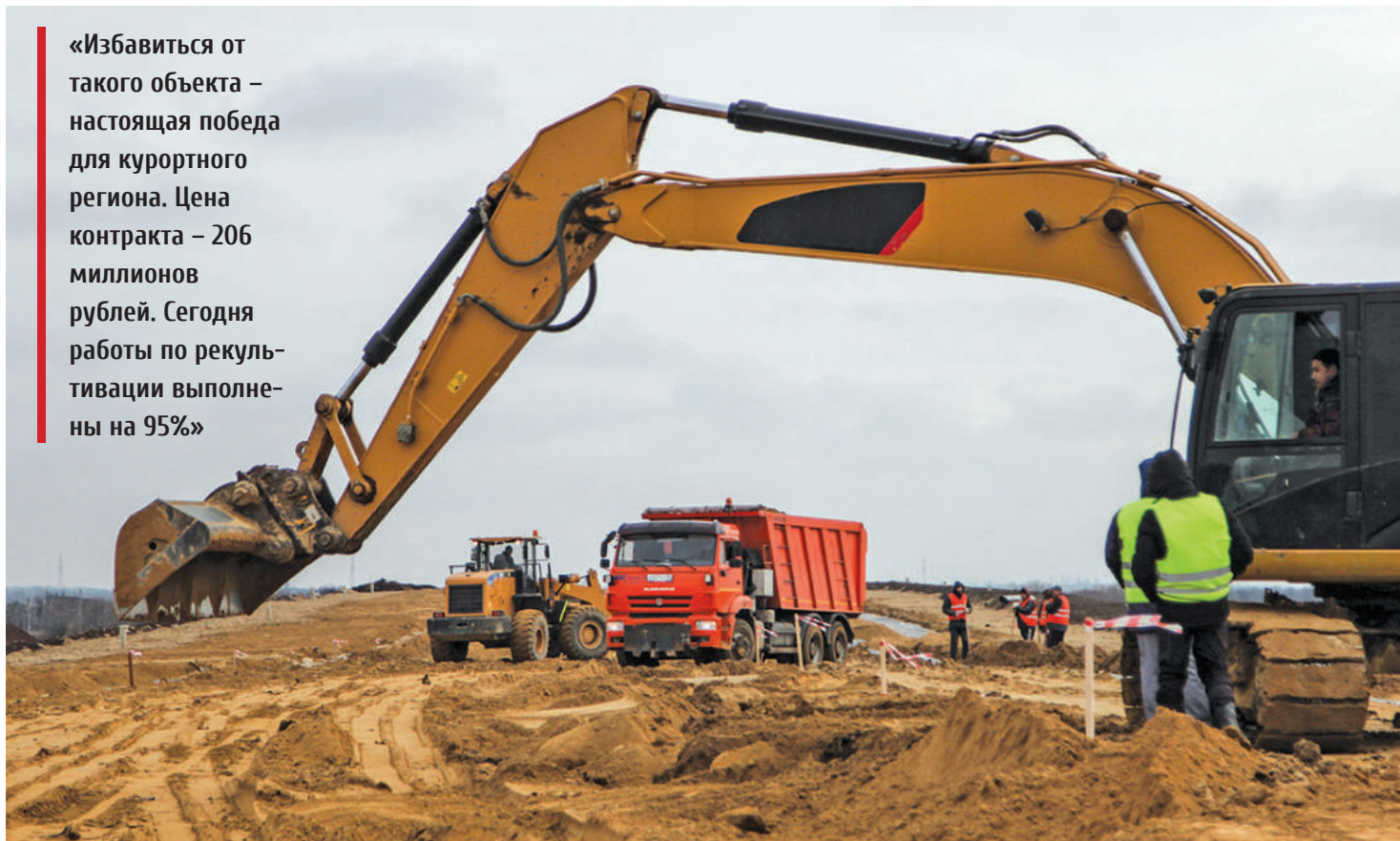
Завершение рекультивации Сакского полигона ТКО. Фото: Михаил ГЛАДЧУК
