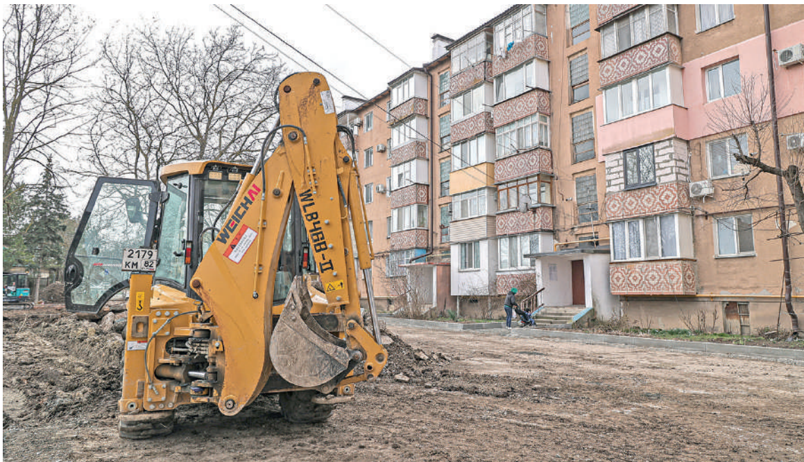
Полным ходом идут работы по благоустройству дворов МКД.
