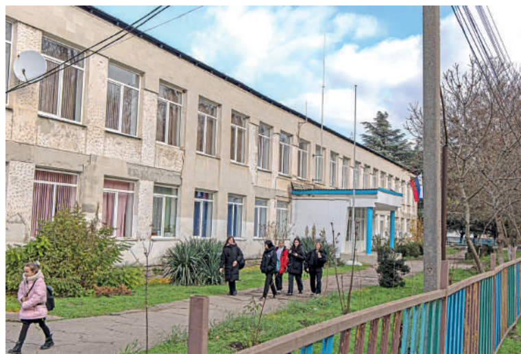
Планируется ремонт фасада школы.
