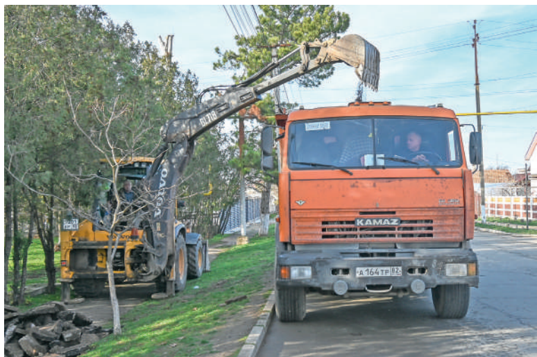
На центральной улице обустривают пешеходные дорожки.
