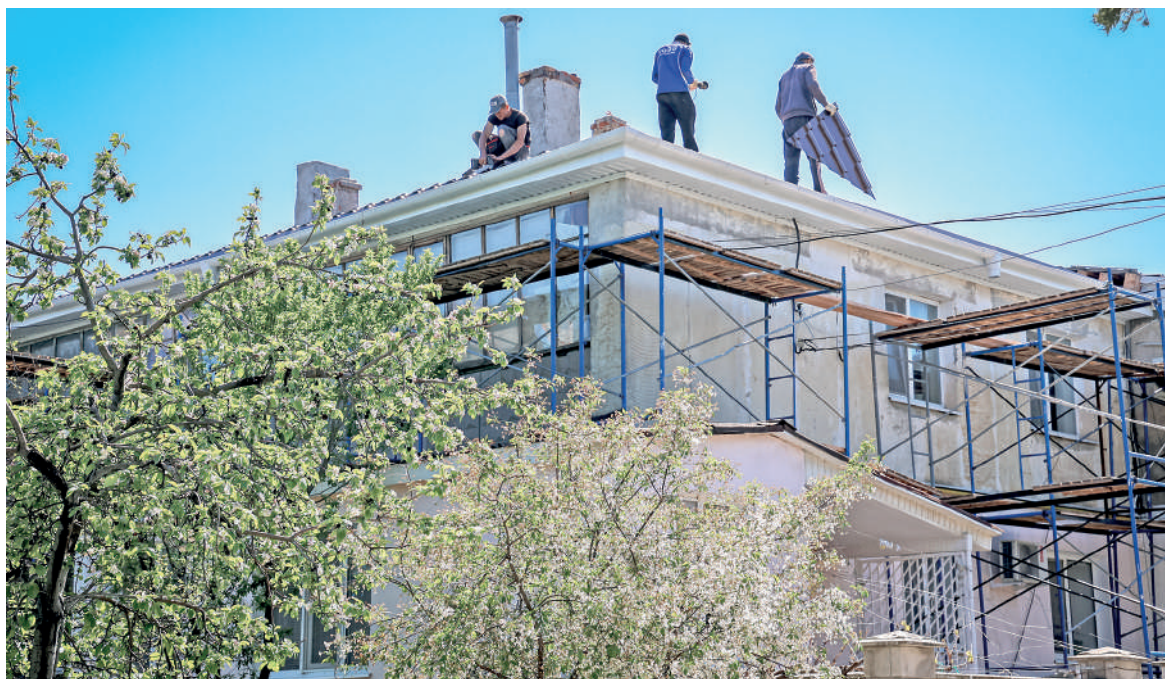
В нескольких многоквартирных домах сейчас идёт капремонт кровель.
