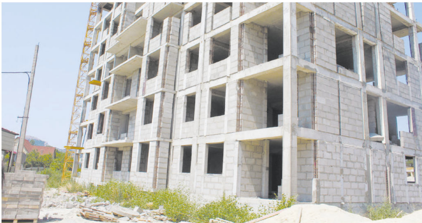
Строительство 72-квартирного дома в Судаке позволит существенно сократить очередь на жильё реабилитированных граждан. Фото: пресс-служба Госкомнаца РК
