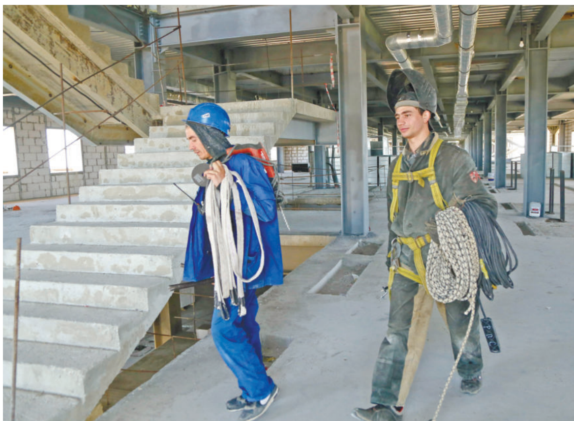
Важный момент на строительной площадке – организация безопасных условий труда. Здесь строго следят за тем, как одет строитель.
