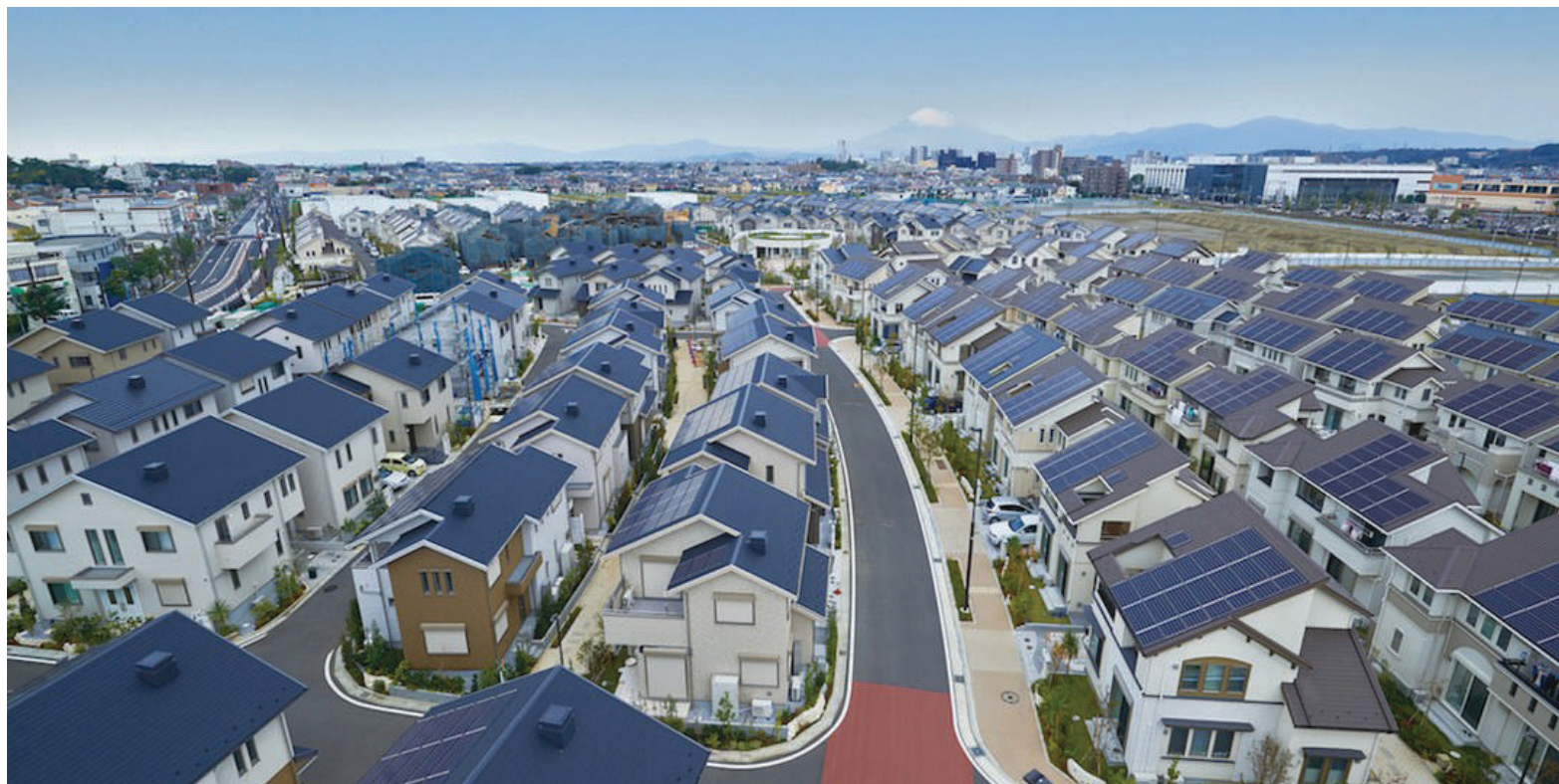
В пригороде Токио при строительстве новых жилых кварталов на всех домах устанавливаются солнечные батареи. Фото: ubergizmo.com
