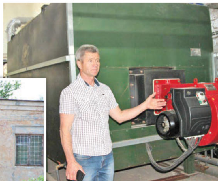
Глава сельсовета Николай Попов показывает новое оборудование котельной Школьного.
