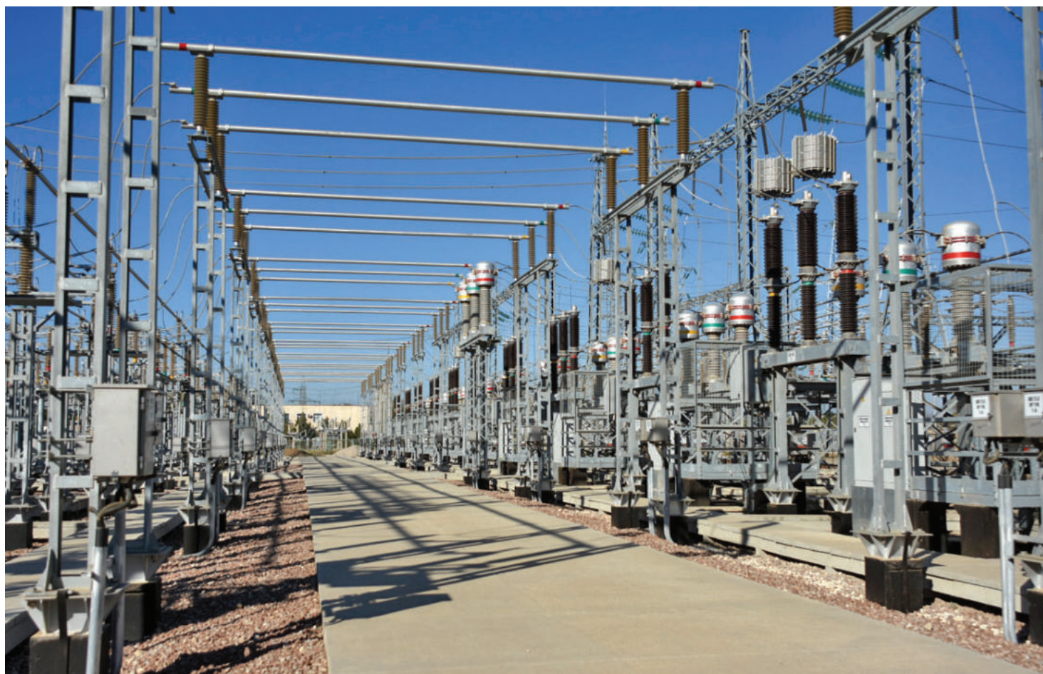
Первую очередь Сакской ТЭЦ построили в рекордные сроки. Фото: Владимир ПРОШКИН
