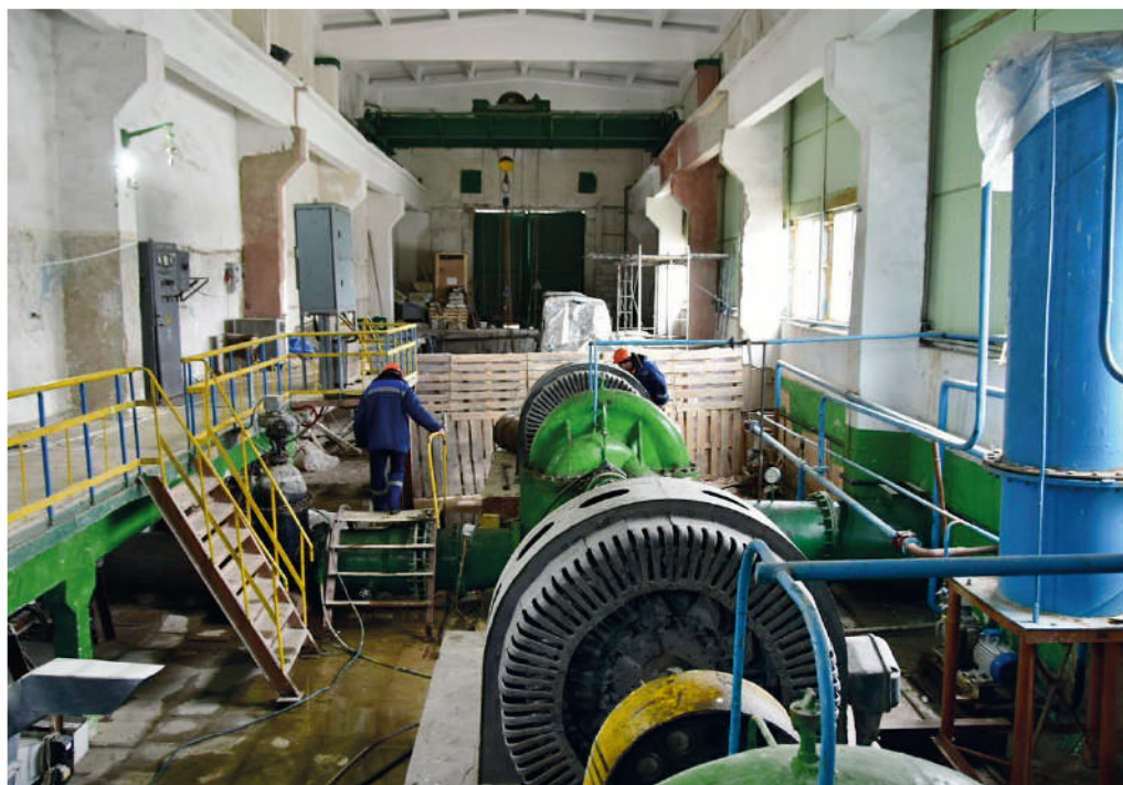
На 16-й насосной станции на Феодосийском водохранилище завершается реконструкция. Фото: Гала АМАРАНДО
