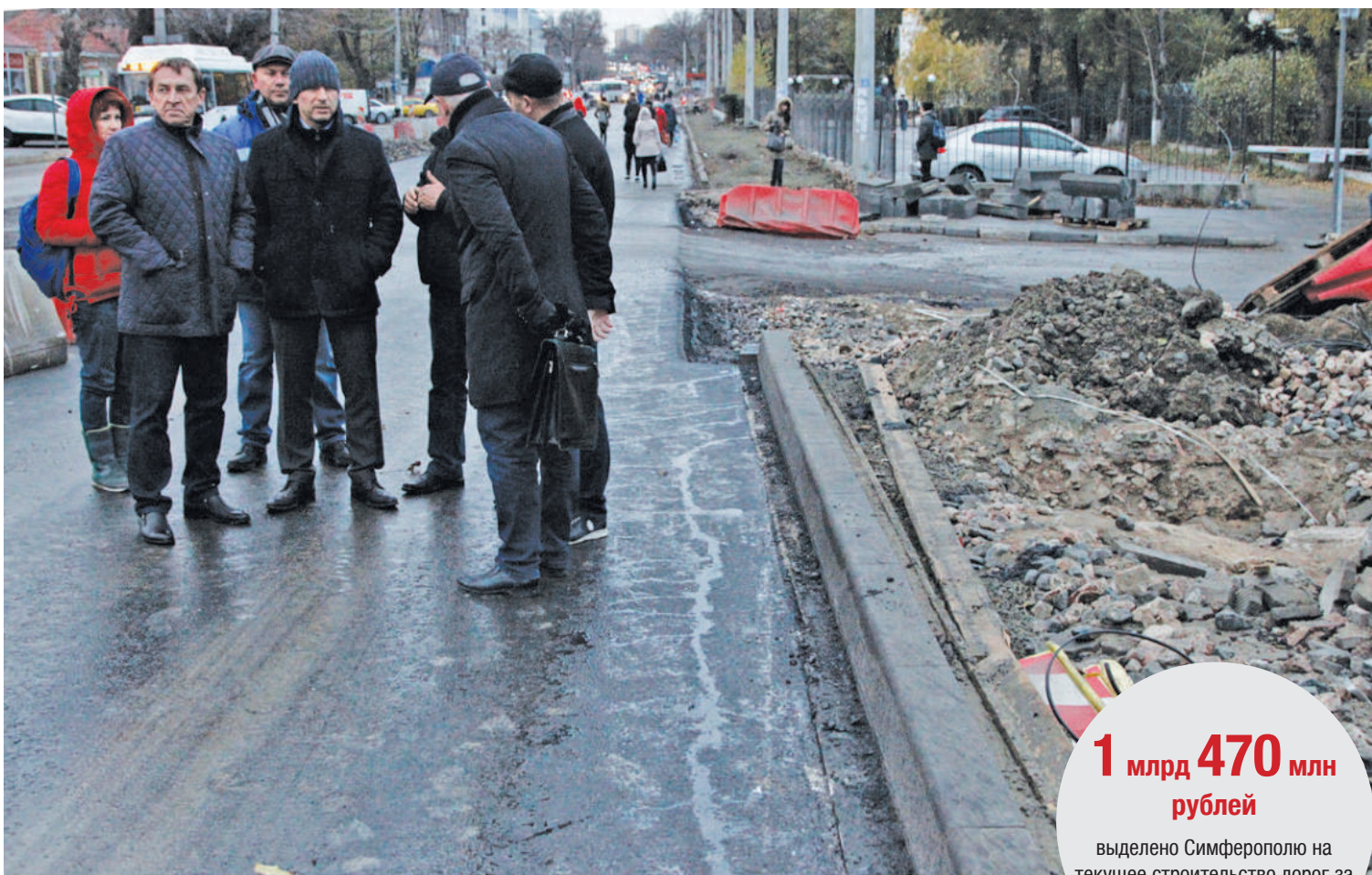
Вице-премьер Юрий Гоцанюк и министр транспорта Сергей Карпов вместе с подрядчиками, заказчиками и стройконтролем осматривают выполненные работы на улице Севастопольской. Фото: Михаил ГЛАДЧУК
