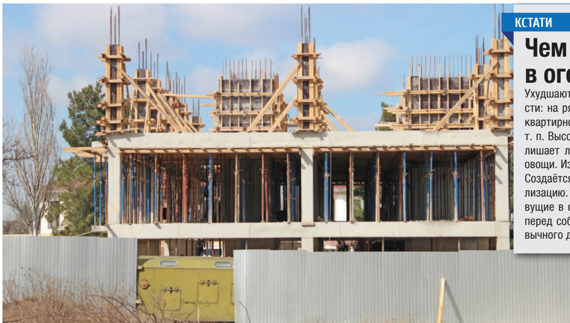
Будущая семиэтажка на улице Трубоченко в Симферополе растёт ускоренными темпами.
