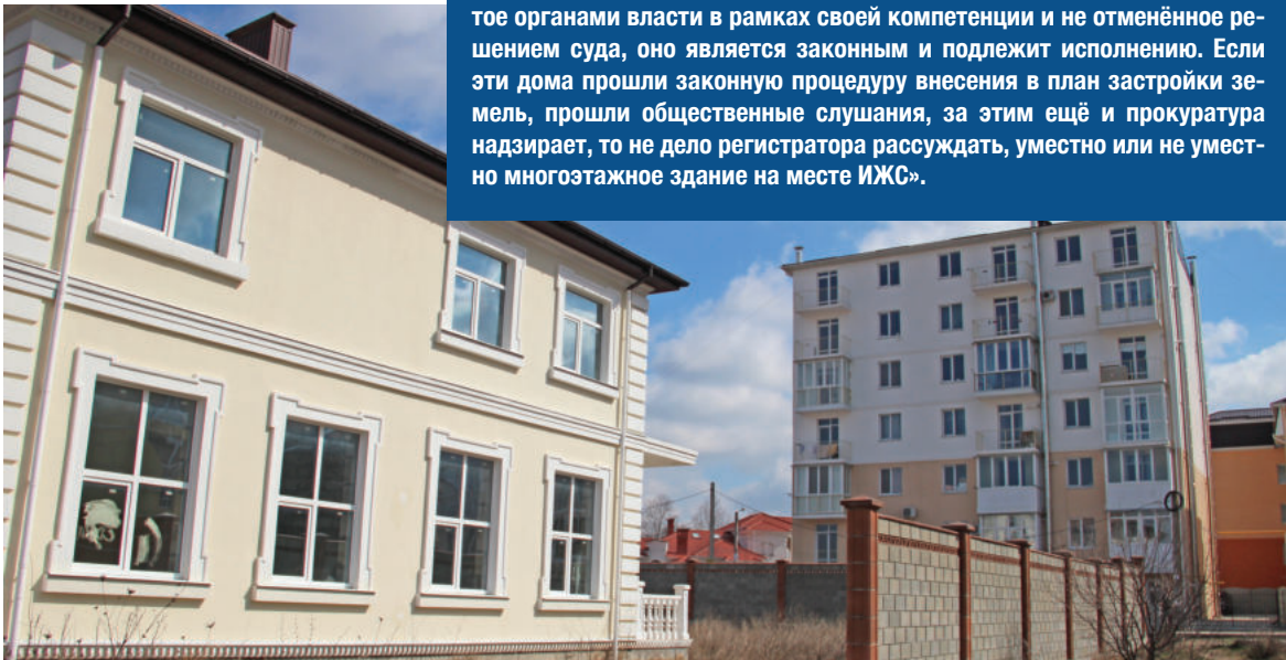
Слева законный коттедж, справа незаконная многоэтажка на улице Батурина в Симферополе.
