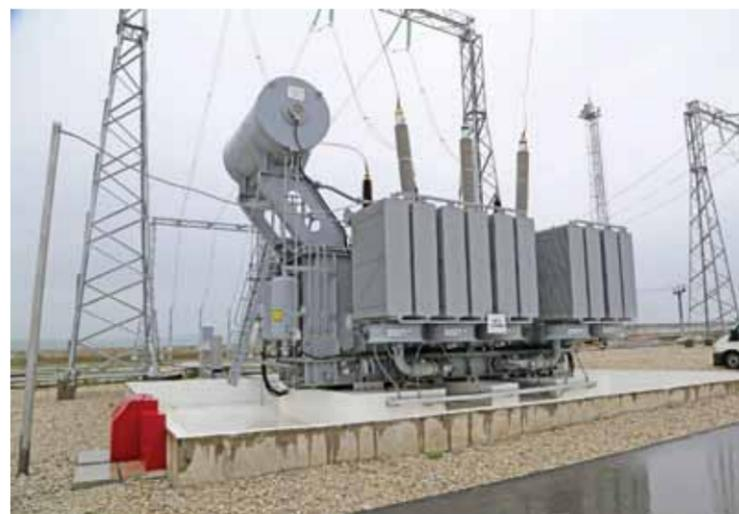
Управляемый шунтирующий реактор.
