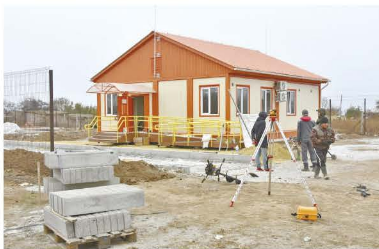
Строительство модульного ФАПа на финишной прямой.
