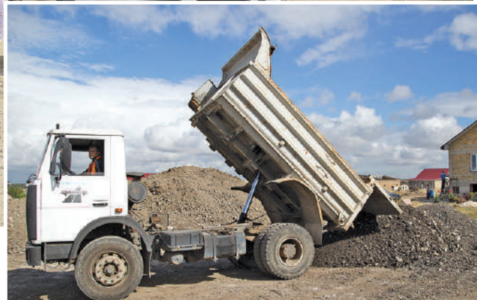
Микрорайон Каменка. Идёт ремонт дороги. Скоро автомобили и жители будут двигаться с комфортом. Фото: Лидия ВЕТХОВА
