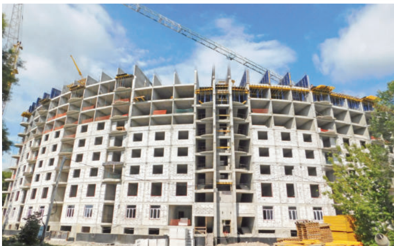
Строительство общежития вуза в Симферополе.
