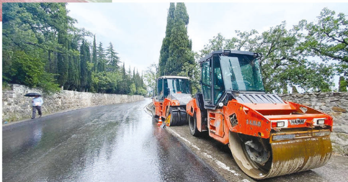
В этом году особое внимание уделили ремонту дорог в рамках нацпроекта «Безопасные качественные дороги».
