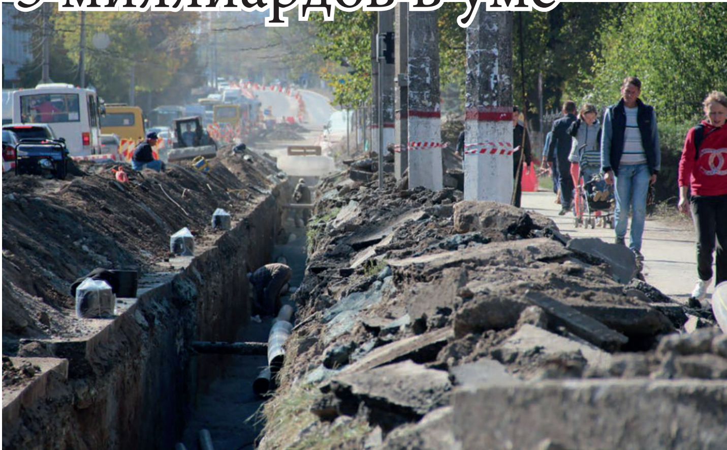
Ремонт на улице Севастопольской, которую разрыли несколько недель назад, вели не по графику. Фото: Михаил ГЛАДЧУК
