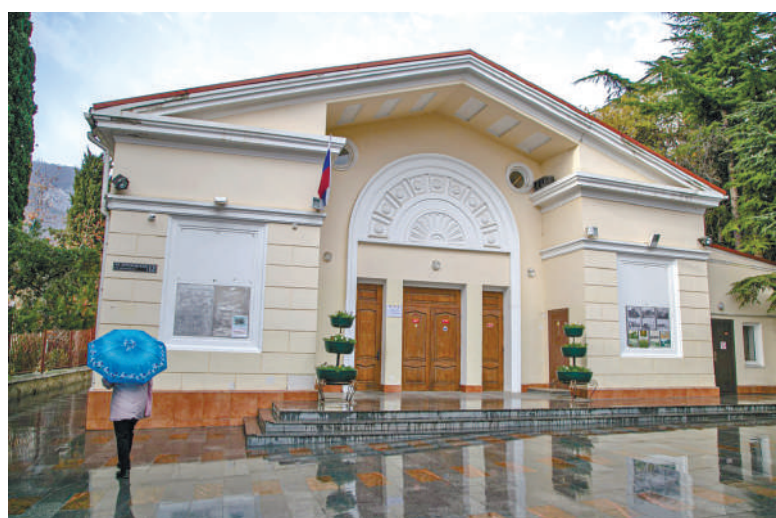
ДК, построенный в 2008 году, находится в отличном состоянии.
