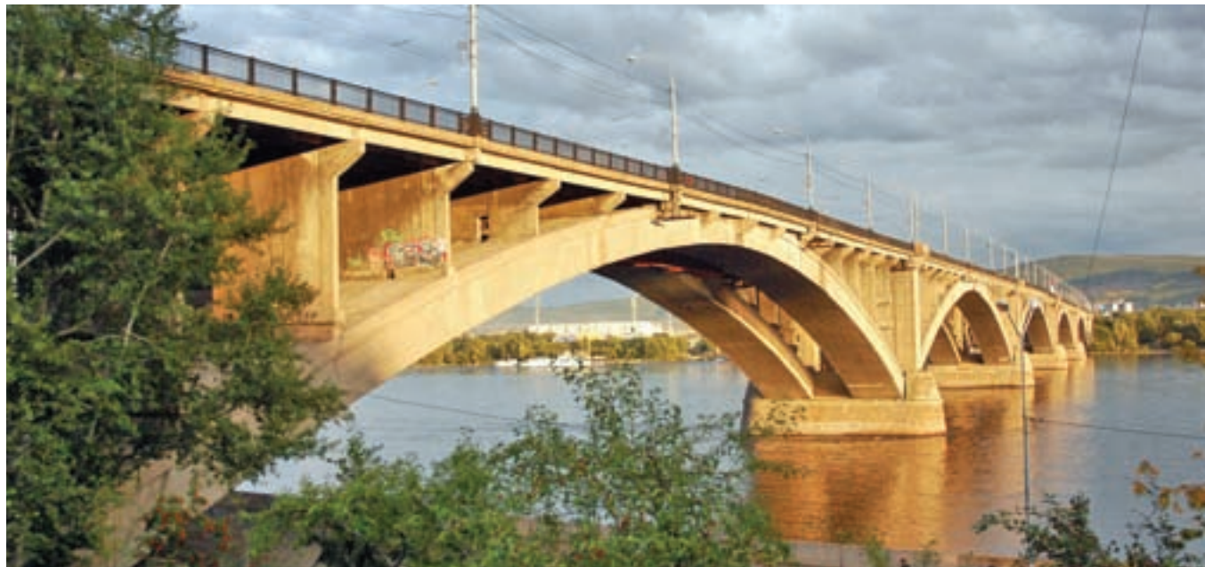
Красноярск. Коммунальный мост.
