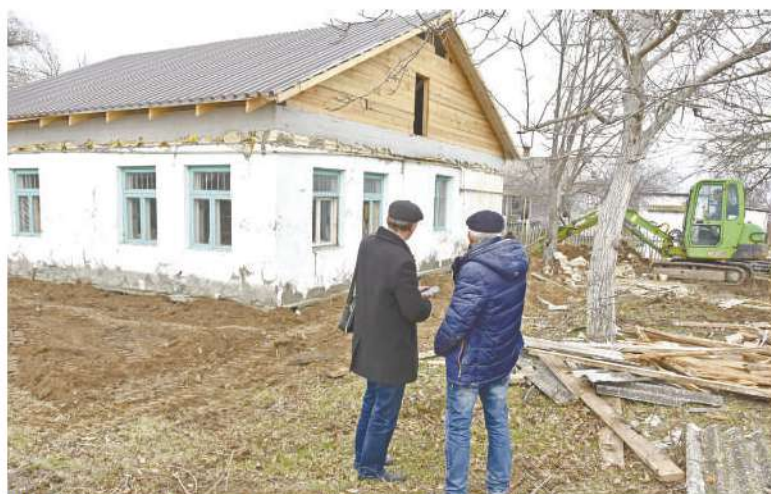
Ремонтные работы на здании ФАПа в самом разгаре.
