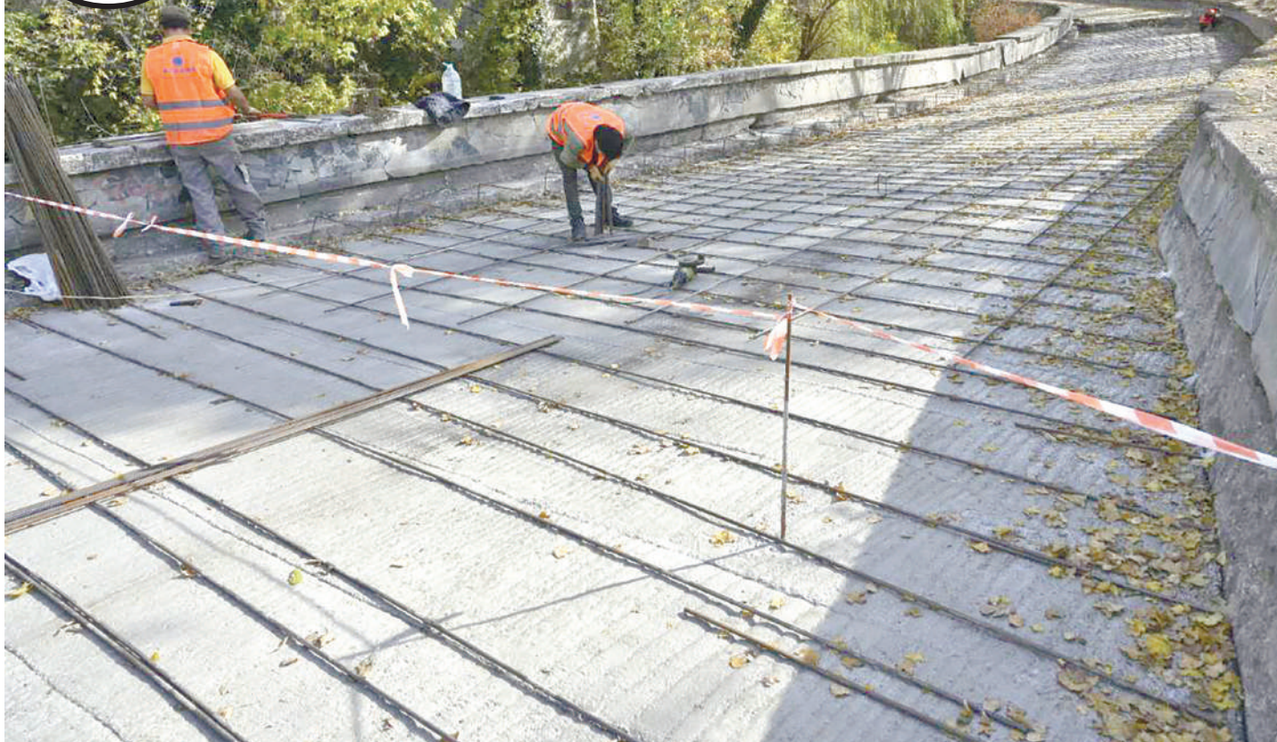
26 октября, Симферополь. Работы на выезде с ул. Линейной на ул. Ким близятся к завершению. Напомним, в прошлом году здесь просело дорожное полотно из-за подмыва грунта. Фото: Гала АМАРАНДО.
