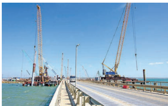
На строительстве транспортного моста через Керченский пролив вбито более 1000 свай.
