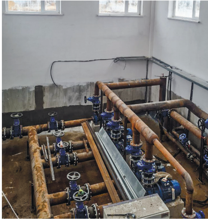
Так выглядят отделочные работы в аппаратном зале водонасосной станции перед испытаниями и пусконаладкой.
