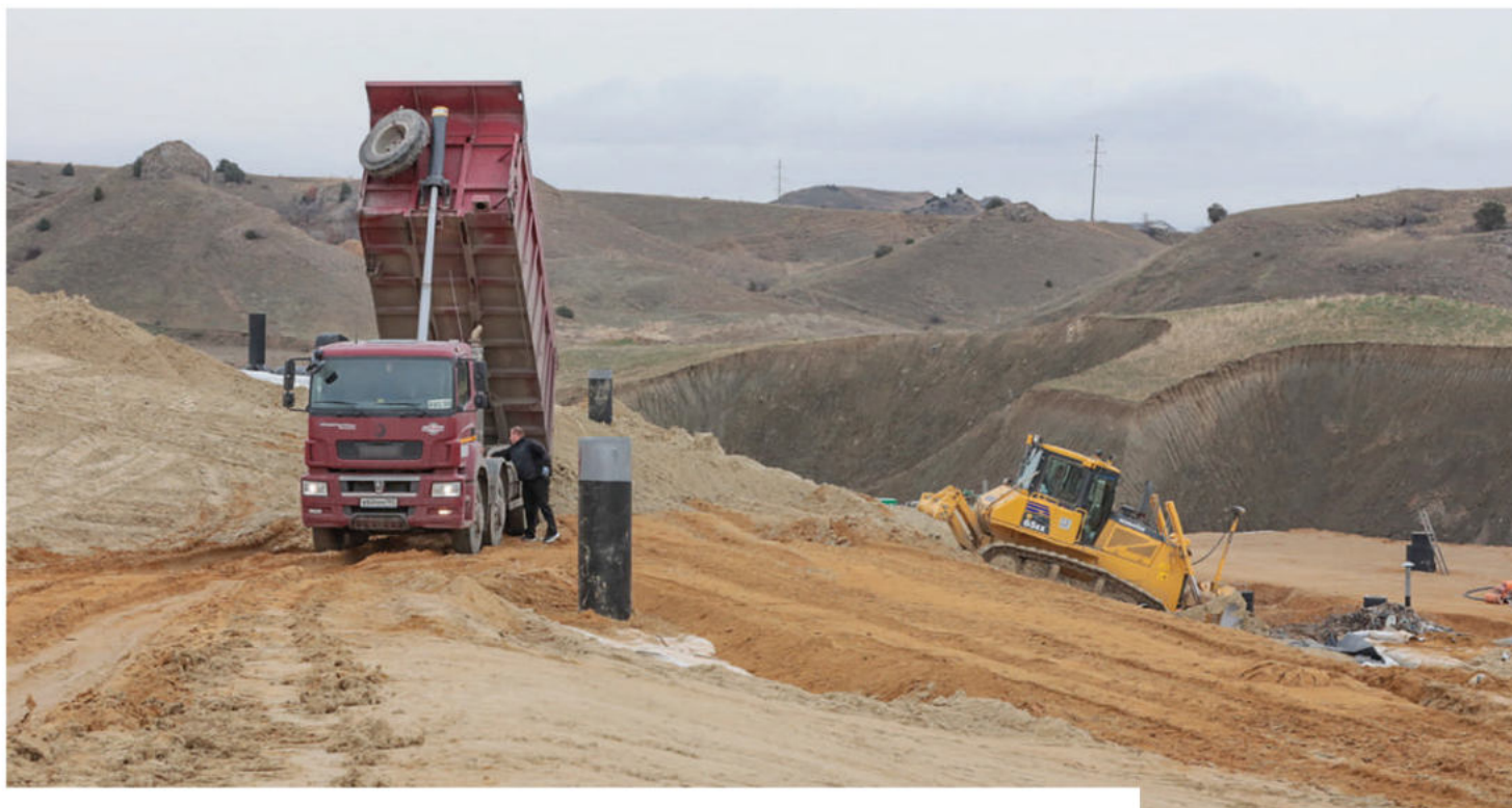
В Судак с опережением графика идёт рекультивация полигона ТБО. Причём по новой методике. Фото: Наталья СОМОВА
