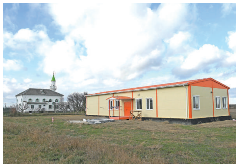
Идут работы по установке модульной амбулатории.
