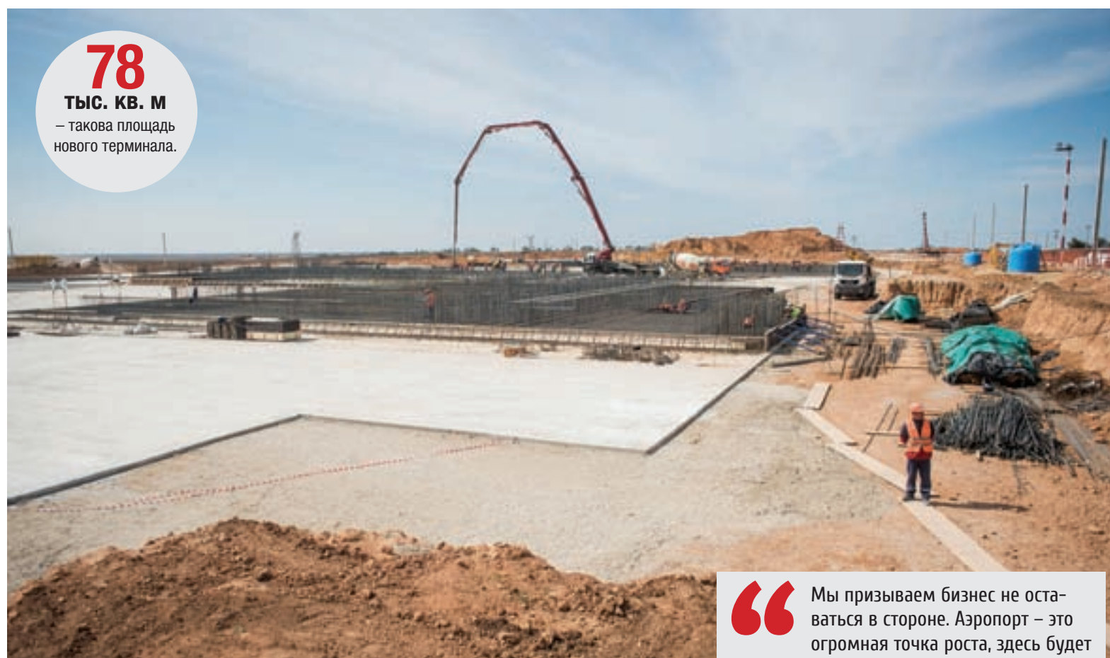
На месте котлована уже устанавливают плиту под будущий терминал. Фото: Антон ВОЛК. Больше фото смотрите на сайте «Газеты» gazetacrimea.ru
