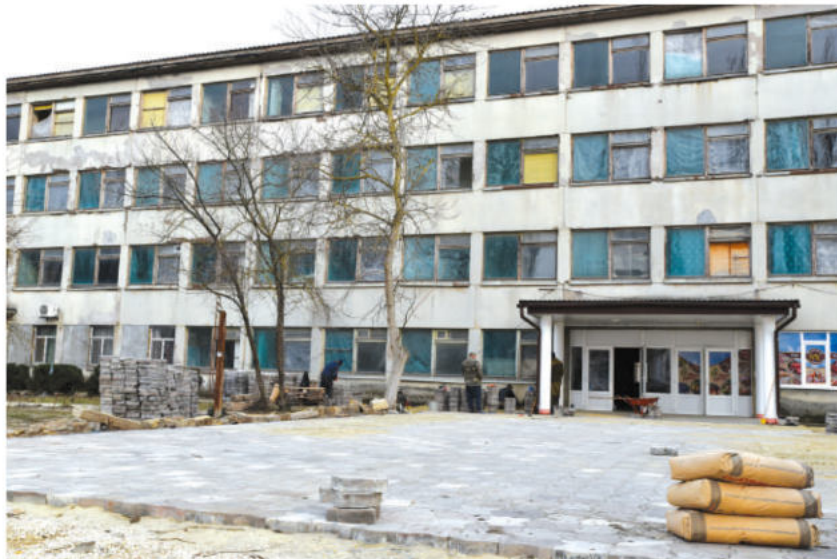
Нижегородский консервный завод. Сейчас здесь идёт текущий ремонт.
