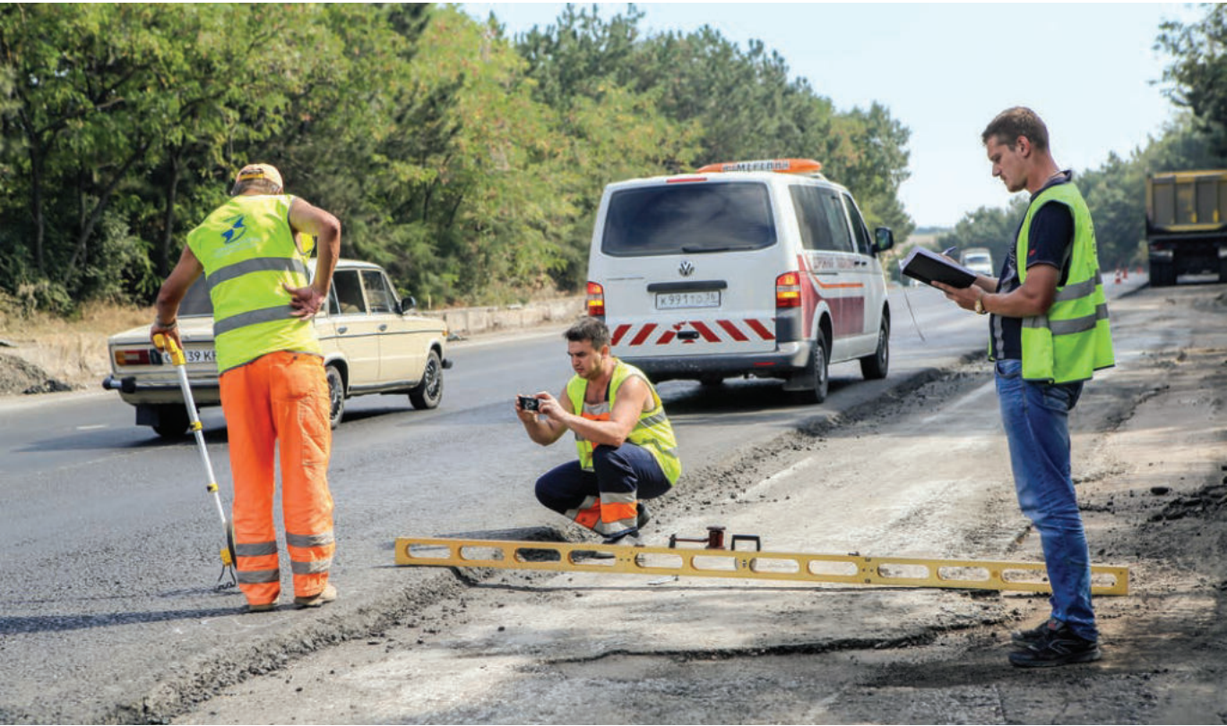
Все этапы строительства дороги контролирует специальная передвижная лаборатория.
