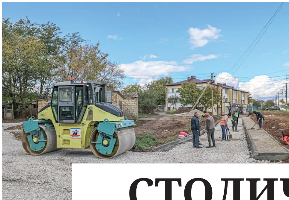
Рабочие занимаются укладкой новых тротуаров.
