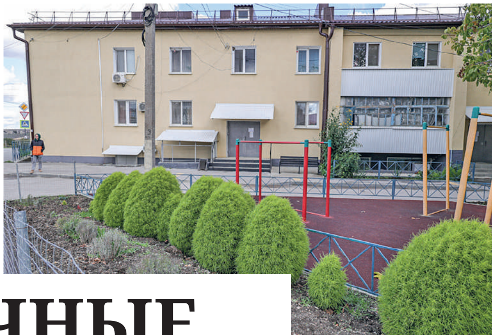
Многоквартирные дома отремонтировали, а территорию вокруг благоустроили.
