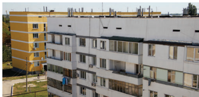
Так выглядят дома № 7 и № 11 на ул. Эдуарда Корпана в пгт Первомайское после ремонта фасада. Фото: Михаил ГЛАДЧУК
