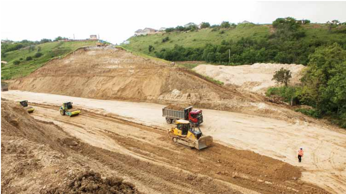
На стройплощадке кипит работа.
