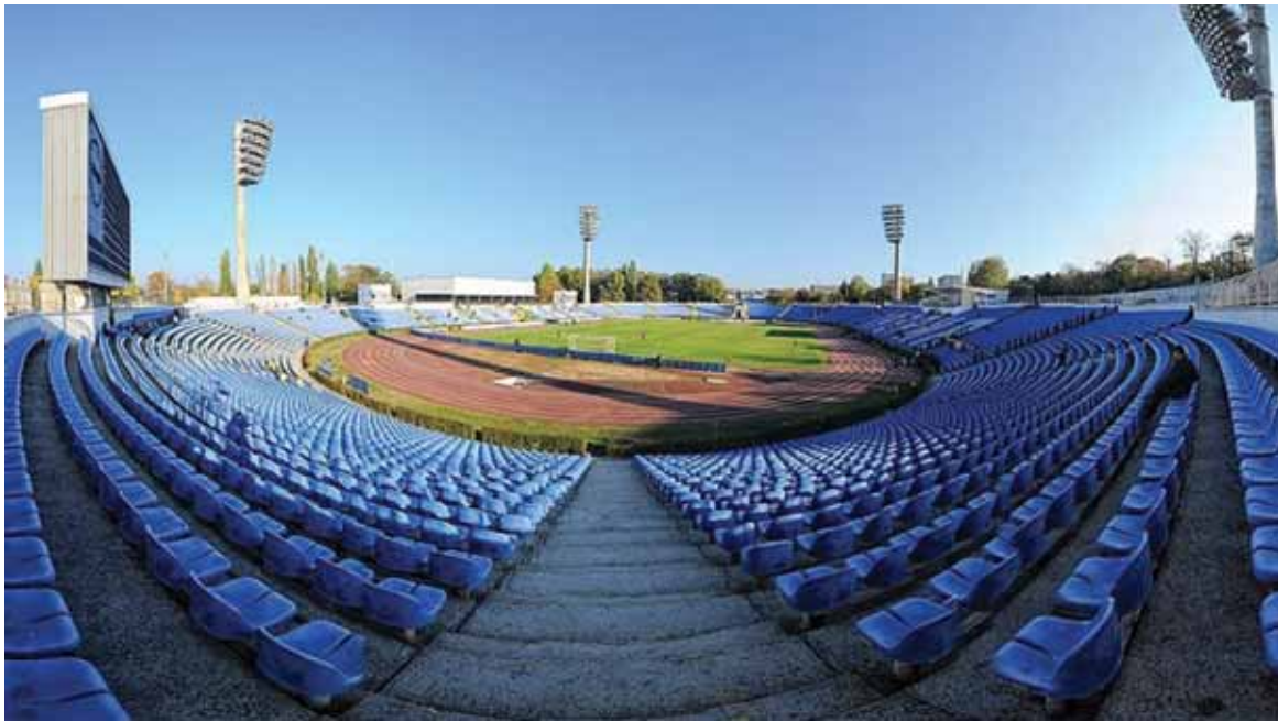
Стадион «Локомотив» реконструируют.
