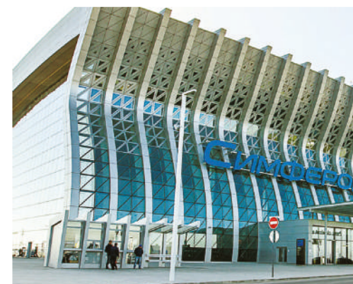
Здание нового терминала аэропорта Симферополя. В будущем рядом будет построена гостиница, коз озером. Фото: архив газеты
