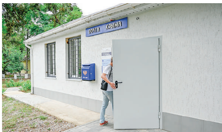
Отделение почты год назад капитально отремонтировали.
