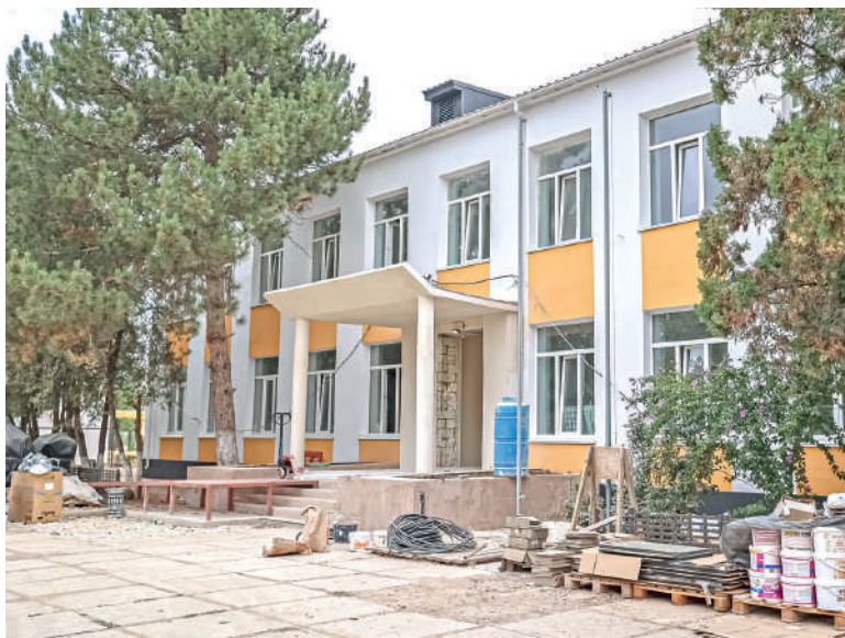
По словам администрации, ремонт школы должны завершить до 1 октября.
