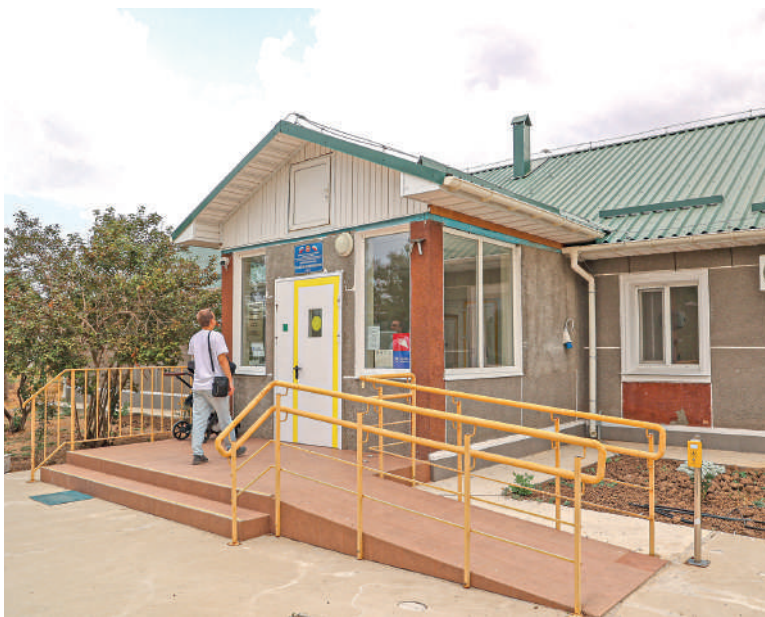
В прошлый наш визит ФАП был ещё на стадии ремонта, сейчас он полноценно работает.
