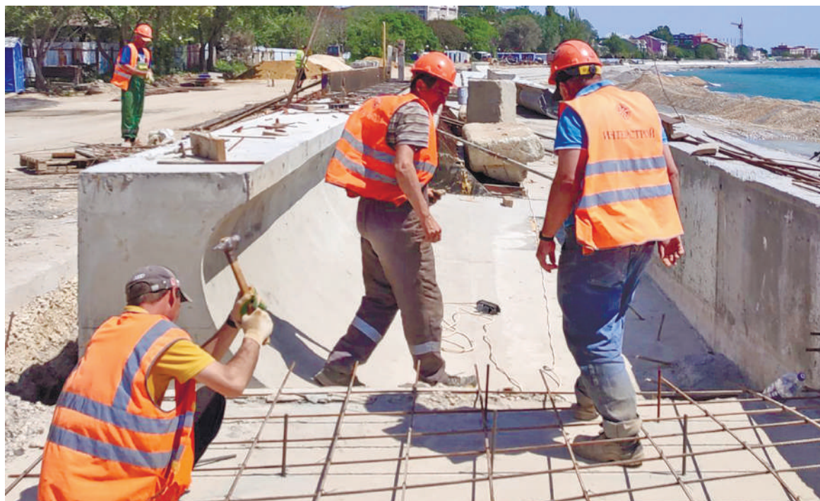
Так производится армирование входных групп на террасной части набережной.
